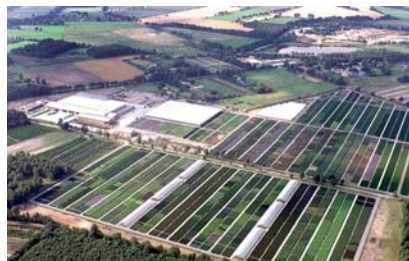
Neubau Containerbaumschule Holm (Deutschland)
