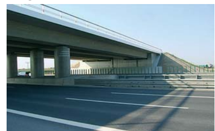
A113n Brücke im Zuge der Zufahrt Airport BBI
