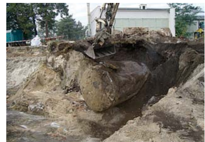
Für die Beräumung des ehemaligen Flugplatzes Cottbus wurde durch das LMI die altlasten- und abfallspezifische Bauvorbereitung geplant und die Rückbauarbeiten überwacht.
