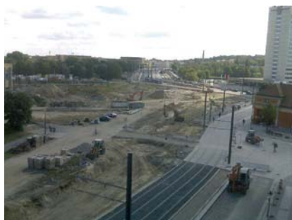
Potsdam, Baufeldfreimachung Potsdamer Mitte
