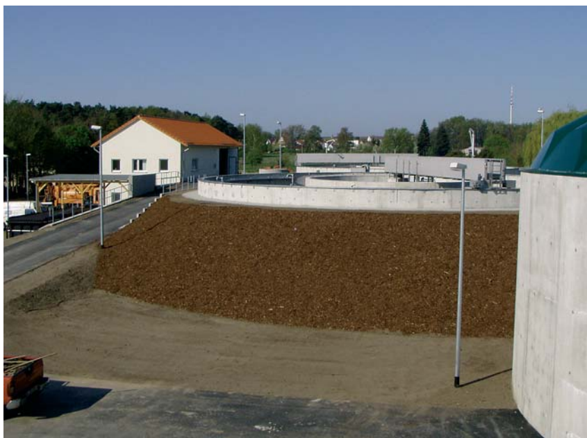
Neubau Kläranlage Calau 8.000 EW, Abwasserreinigung mit Nitrifikation und Denitrifikation, Baujahr 2006
