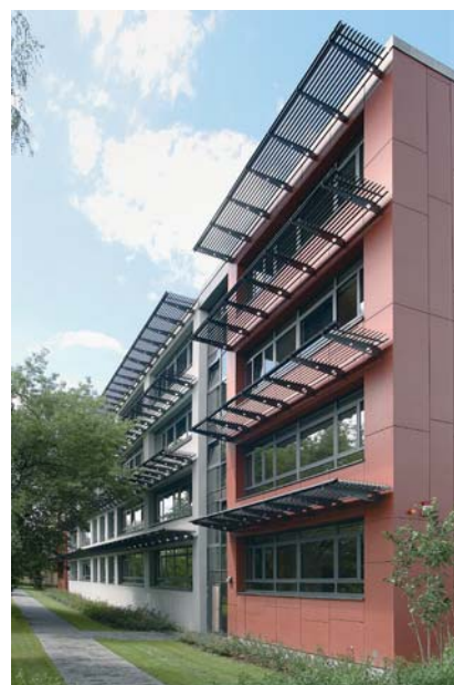
Ansicht Südseite, Trakt I
