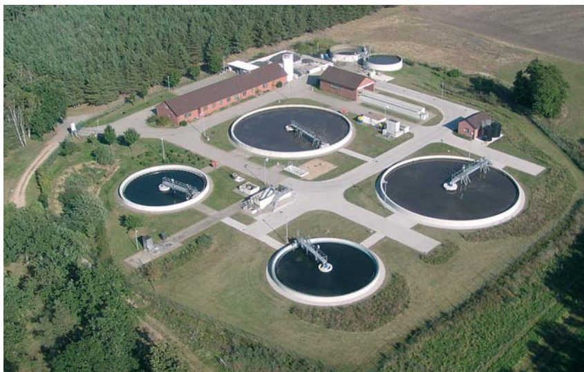
Kläranlage des Abwasserzweckverbandes Planetetal in Brück nach der Fertigstellung der zweiten Ausbaustufe
