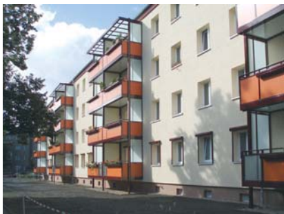
Berlin-Pankow: Wohnhäuser in diversen Straßen im Tiroler Viertel (Generalplaner), Komplexsanierung seit 2004 mit Fördermitteln der KfW.
