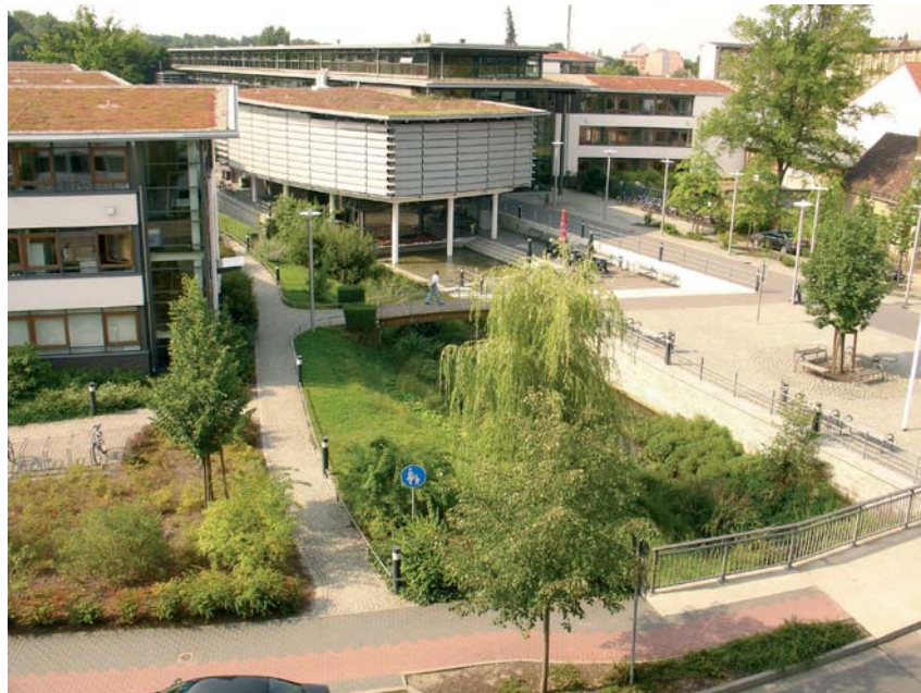
Außenanlagen Kreishaus Luckenwalde
