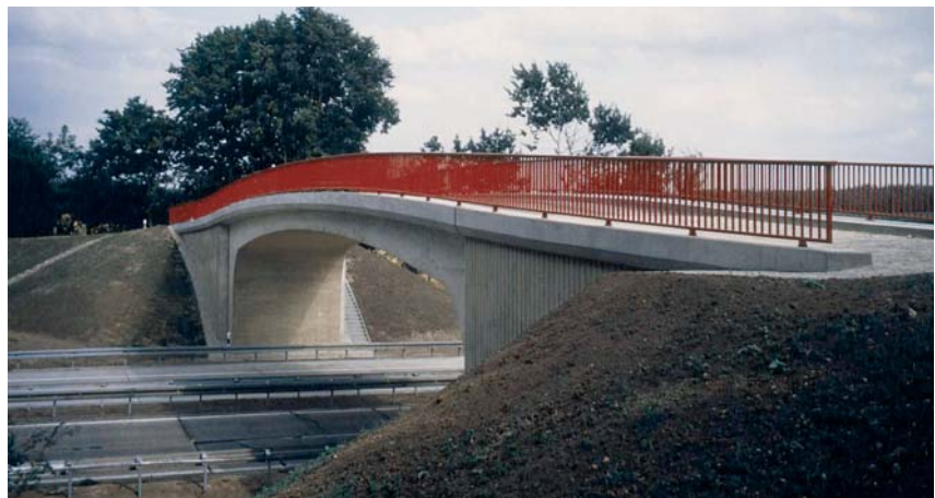
Stahlbetonrahmen über die A 11
