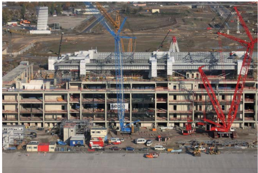
Bautechnische Prüfung: Fluggastterminal Flughafen BBI Berlin-Brandenburg International, Schönefeld
