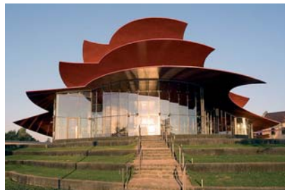
Bautechnische Prüfung: Hans-Otto-Theater, Potsdam
