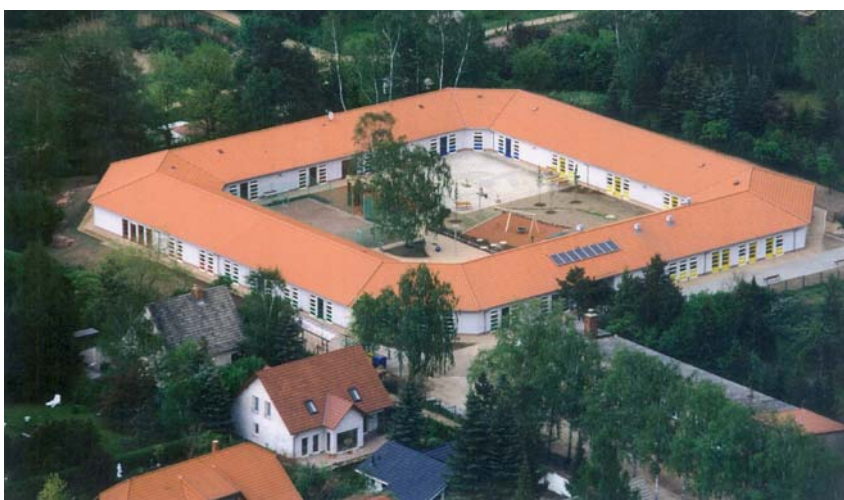
Belzig: Neubau einer Förderschule für 70 geistig und körperlich schwerstbehinderte Kinder, eingeschossiger Rundbau mit farbig untersetzten Sektionen einschließlich Ausstattung und Freianlagen.
