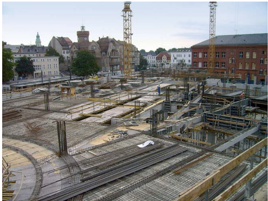
Für den Neubau des Carl-Blechen-Carré in Cottbus wurde durch das LMI das Grundwassermanagement organisiert und überwacht und die Sicherheitskoordination nach Baustellenverordnung übernommen.
