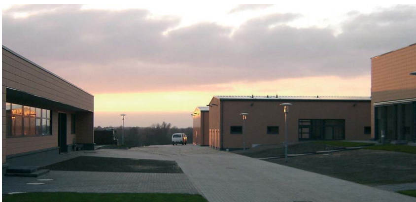
Potsdam-Marquardt: Neubau einer Maschinenhalle und eines Werkstattgebäudes für das Bundessortenamtm.
