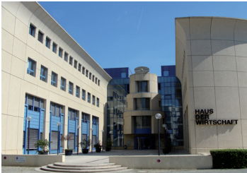
Geschäftsstelle der Brandenburgischen Ingenieurkammer
