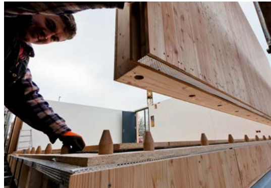
Abbildungen 8.5: Klassenraum der mobispace Schule, Abb. 8.6: Reversible Steckverbindung als Montagehilfe I mobispace, © Thomas Ott
