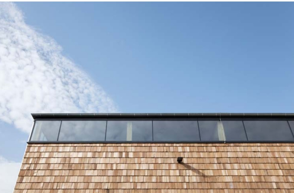
Abbildungen 7.1 und 7.2: Schindelfassade Betriebsgebäude Artis | ZRS Architekten Ingenieure, © Daniela Friebe
