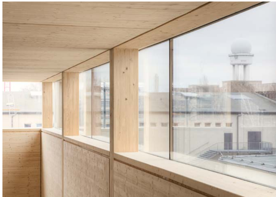
Abb. 7.6: Dreischichtplatten Betriebsgebäude Artis GmbH | ZRS Architekten Ingenieure © Daniela Friebe
