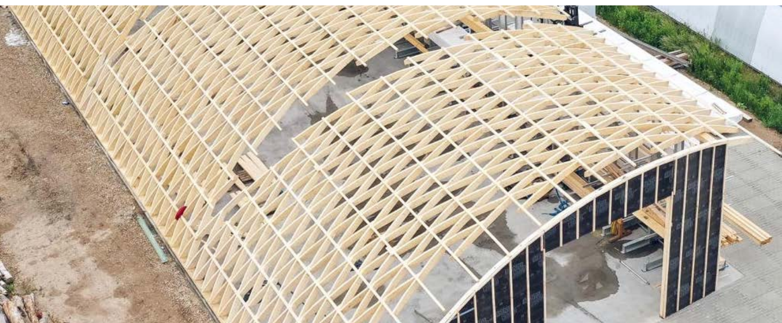
Abb. 11.02: Bogenhalle © Elite Holzbau GmbH & Co. KG.
