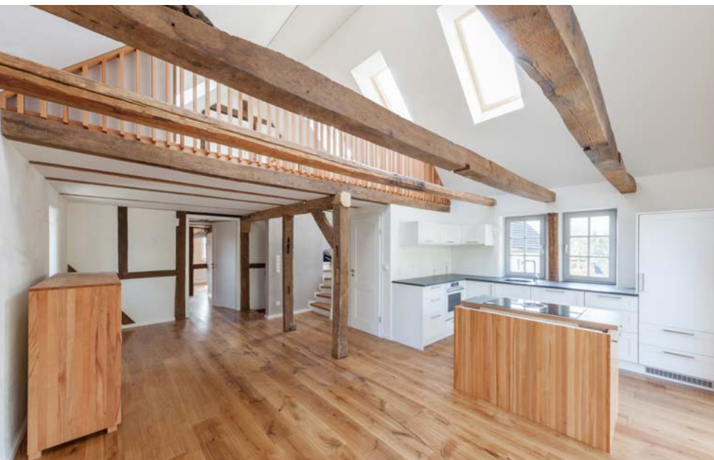
Abbildungen 7.7 und 7.8: Fachwerkbau nach Sanierungsmaßnahmen, © ZRS Architekten Ingenieure
