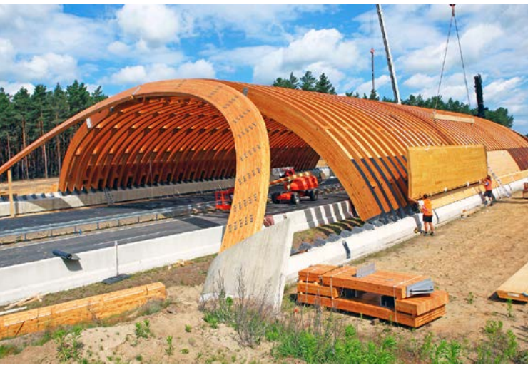
Abb. 11.16 und 11.17: Bogentragwerk aus Brettschichtholz Grünbrücke Luckenwalde. Schwesig + Lindschulte, © René Legrand
