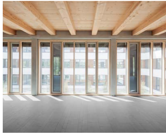
Abb. 7.16: Holz-Beton-Verbundsystem-Decke, Firmengebäude Flexim, © ZRS Architekten Ingenieure
