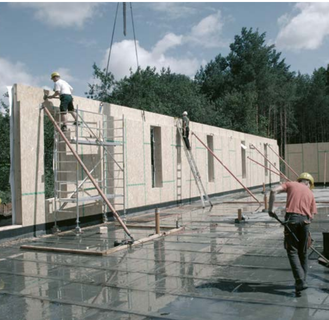
Abbildungen 7.9 und 7.10: Holzrahmenbau und Holztafelbau im Neubau, © ZRS Architekten Ingenieure
