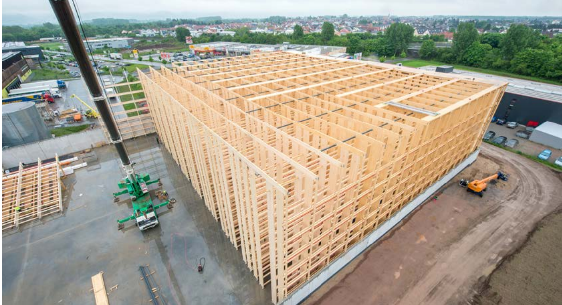
Abbildungen 3.5 und 3.6: Innovativer Ingenieurbau: Alnatura Hochregallager aus Holz. BFK Architekten, © Marc Doradzillo
