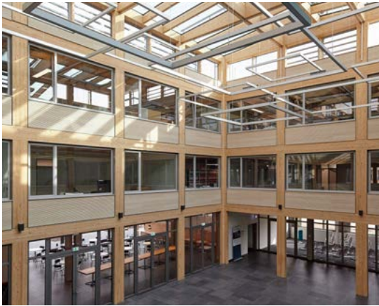
Abb. 7.15: Foyer Firmengebäude Flexim, © ZRS Architekten Ingenieure
