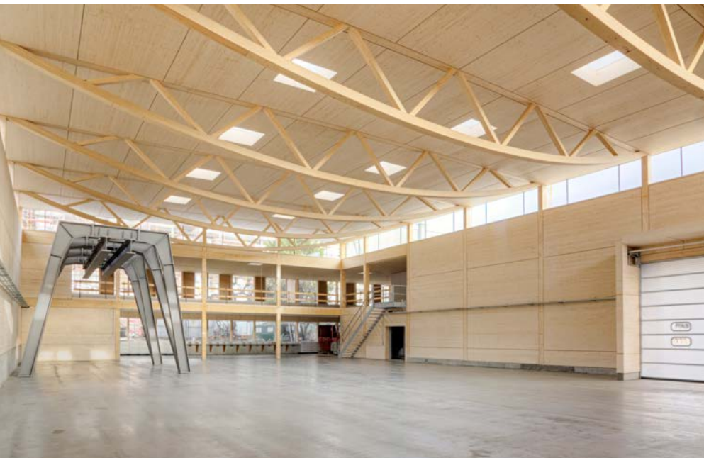
Abbildungen 7.3 und 7.4: Fischbauchträger Betriebsgebäudes Artis aus Konstruktionsvollholz, ZRS Architekten Ingenieure, © Daniela Friebe
