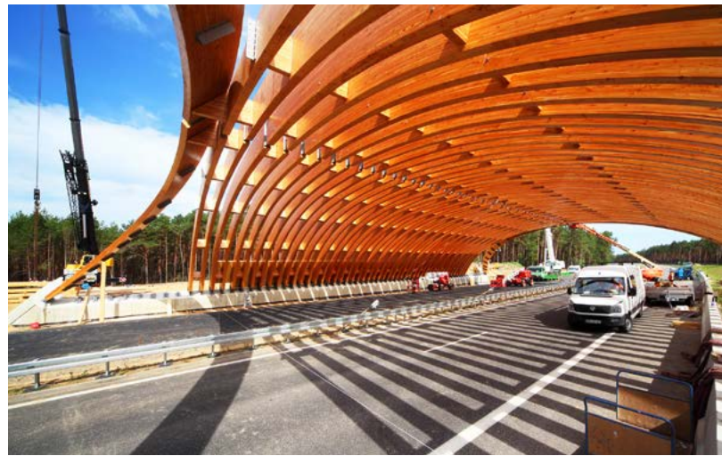
Abb. 11.16 und 11.17: Bogentragwerk aus Brettschichtholz Grünbrücke Luckenwalde. Schwesig + Lindschulte, © René Legrand
