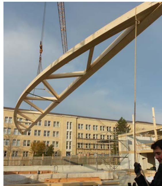
Abbildungen 7.3 und 7.4: Fischbauchträger Betriebsgebäudes Artis aus Konstruktionsvollholz, ZRS Architekten Ingenieure, © Daniela Friebe
